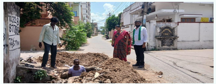
సందిగామ పట్టణం : స్థానిక 14వ వార్డులోని సైపర్లైను మరమ్మత్తు పనులను పరిశీలిస్తున్న మున్సిపల్ చైర్ పర్సన్ మండవ కృష్ణకుమారి ఈ కార్యక్రమంలో మార్కెట్ యార్డ్ వైస్ చైర్మన్ అమ్మినేని జ్ఞాని ప్రసాద్ పాల్గొన్నారు.
